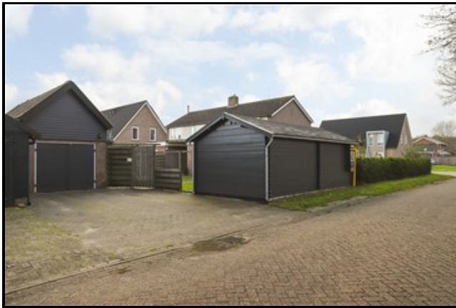
Zicht vanaf de straat
